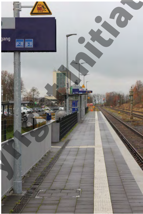
Abbildung 68: Neuer Bahnsteig Werneuchen Gleis 1 (Foto: Theißen)
