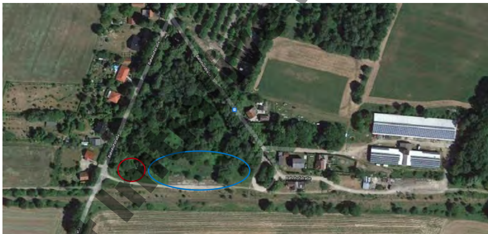
Abbildung 43: Bahnhof Leuenberg mit Flächen für Pkw- und Fahrradabstellung sowie Buswendeschleife (Quelle: Google Maps, Bearbeitung: Theißen): Pkw-Stellplätze auf dem ehemaligen Ladeplatz (blau), Fahrradabstellung (rot).
