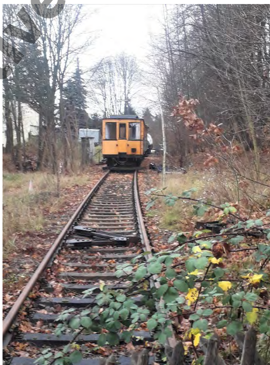
Abbildung 20: Links des Gleises sollte der neue Haltepunkt Tiefensee errichtet werden. Derzeit ist hier der Beginn der Draisinstrecke (Foto: Wagner)
