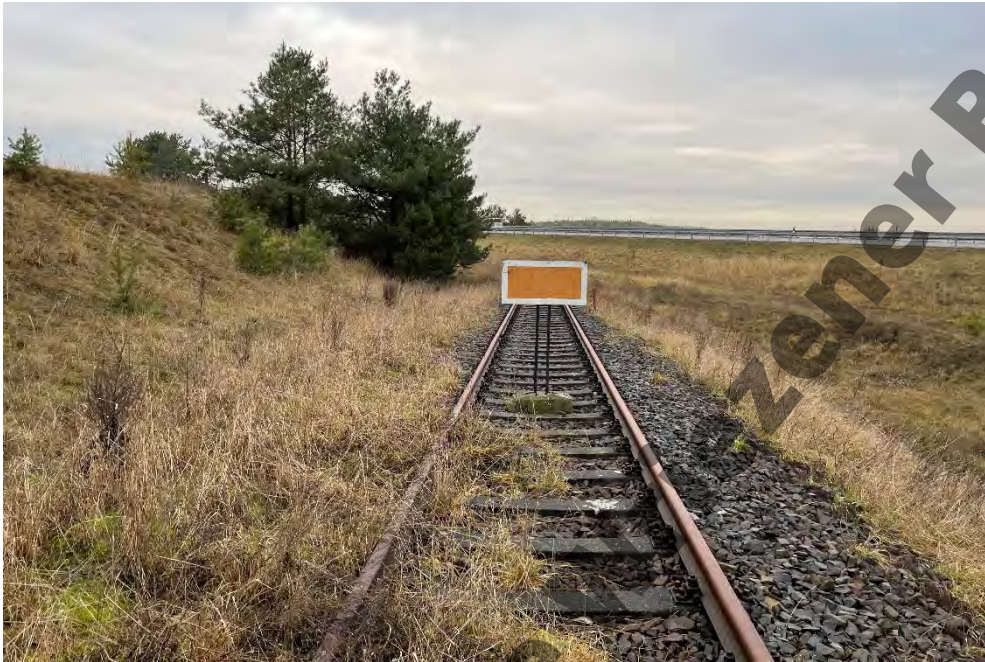
Abbildung 13: Derzeitiger Streckenzustand aus Richtung Schulzendorf (Foto: Ranft)
