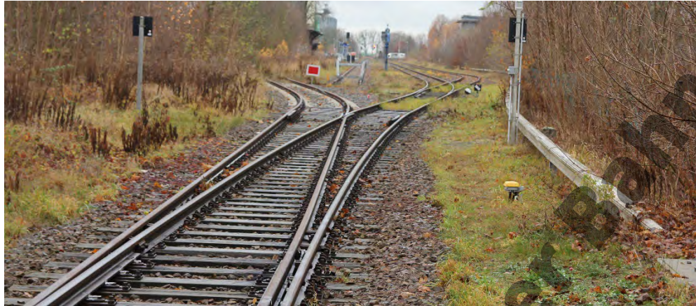
Abbildung 70: Einfahrt aus Richtung Wriezen in den Bahnhof Werneuchen, gut erkennbar das fehlende Gleisstück zur Anbindung an das Gleis 1 (Foto: Theißen)
